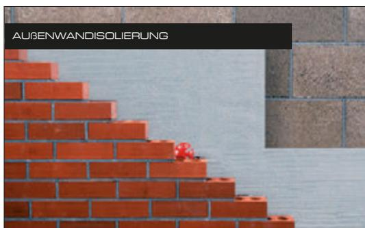
z.B. dreischaliges Mauerwerk, Isolierung einer einschaliger Mauer
