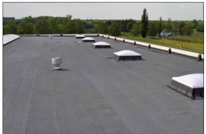
Die Dachpappe wird direkt an die Außenschale des TB /TB FR mittels Gasbrenner angebracht.
