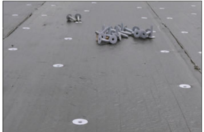
Zum System gehören auch Befestigungselemente. Profile, die das Wasser in die Rinnen ableiten, müssen vor dem Anbringen der Pappenschale montiert werden.
