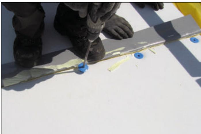
Verbindung der Platten mit zugelassenen Befestigungsschrauben
