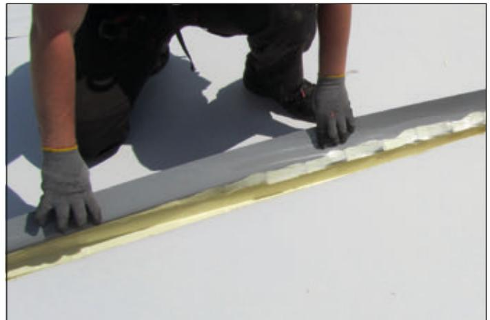
Längsüberlappung beim System ThermaMembrane
