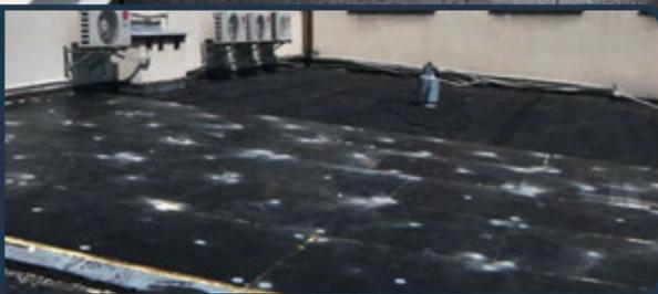
Bei der Verwendung eines PUR-Kerns, können die **ThermaBitum**-Platten um die Hälfte dünner sein, als andere Systeme, z.B. mit Styropor oder Mineralwolle. Dies hat eine entscheidende Bedeutung bei der Höhe der Feuerschutzmauern, die bei der Modernisierung eines Flachdachs, die Plattenverlegung einschränken können.
