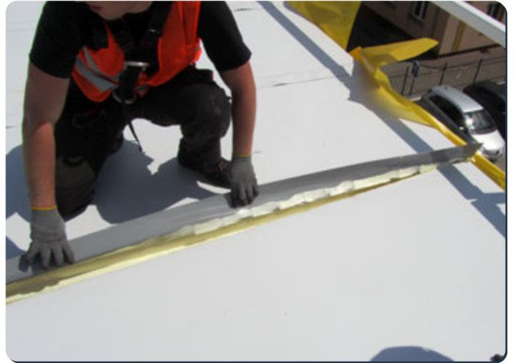
Überlappungsmembran an den Längsstoß
