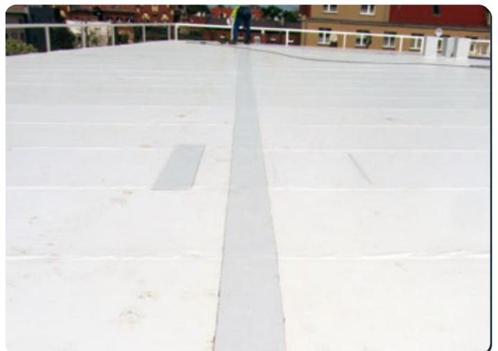
Querstoß mit einem angeschweißtem Membranstreifen
