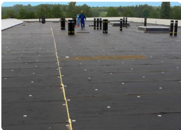
Montage der Platten ThermaBitum auf der ganzen Dachdeckschicht
