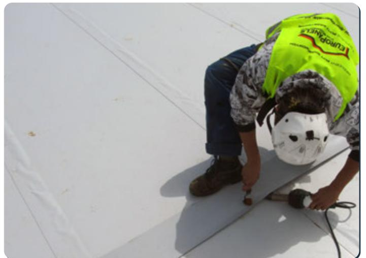
Handschweißen- Membranstreifen an der Querverbindung
